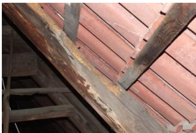
6) Poškození kombinovanou činností dřevokazných hub a hmyzu
