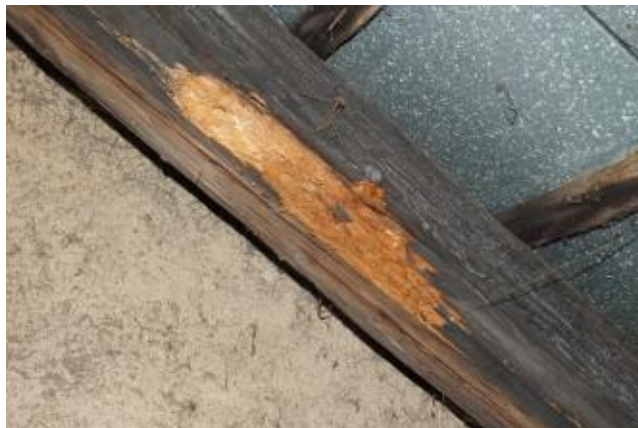
8) Poškození činností dřevokazného hmyzu
