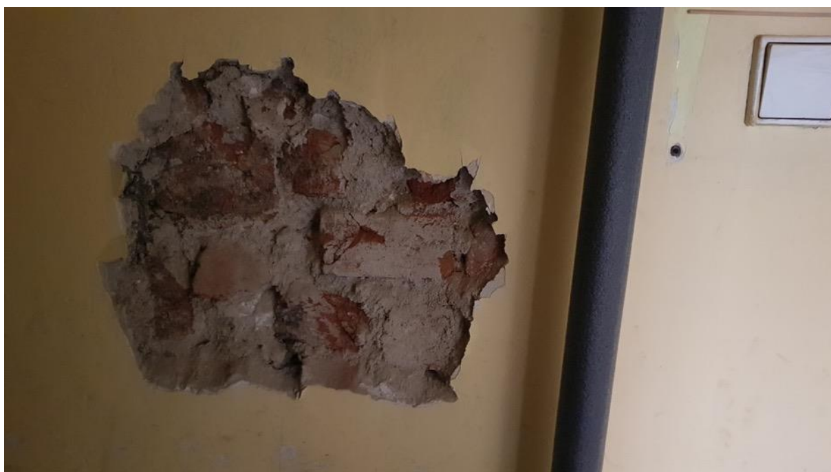
Foto 6: Pohled na sondu Z06 – cihelné zdivo
