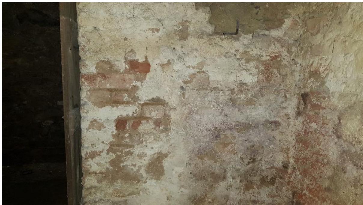
Foto 3: Pohled na sondu Z04 – smíšené zdivo
