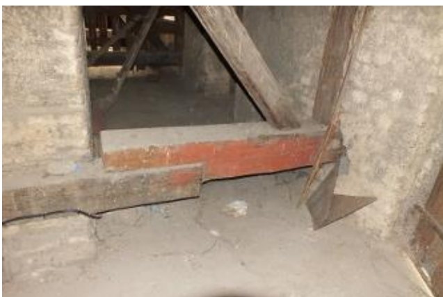
11) Provizorní oprava vazného trámu
