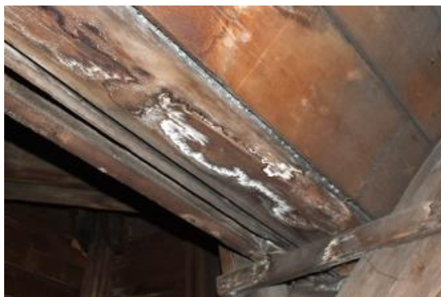
10) Stopy po zatékání srážkové vody
