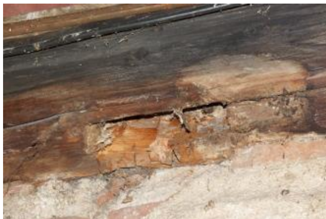
2) Poškození činností dřevokazných hub
