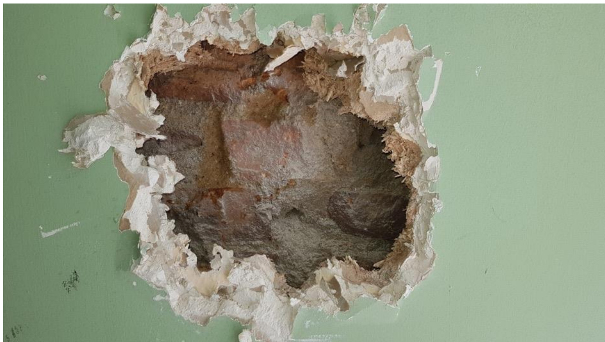
Foto 5: Pohled na sondu Z05 – cihelné zdivo
