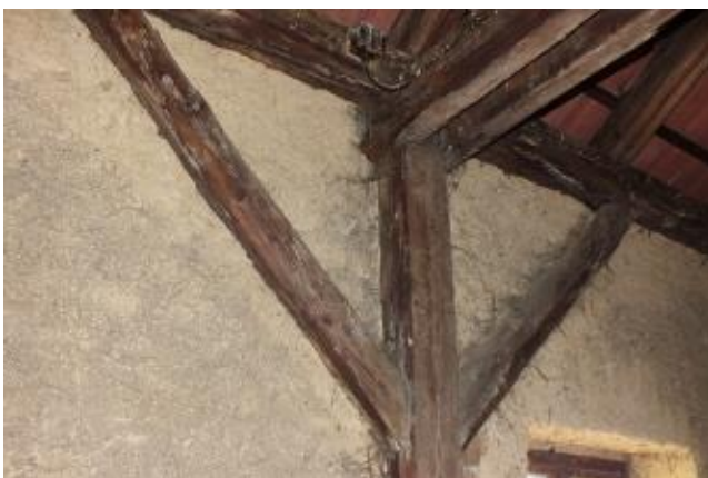
9) Prvky částečně skryté ve zdivu
