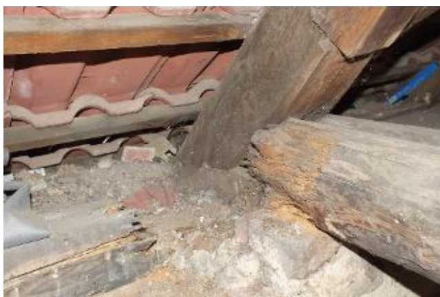
5) Poškození kombinovanou činností dřevokazných hub a hmyzu
