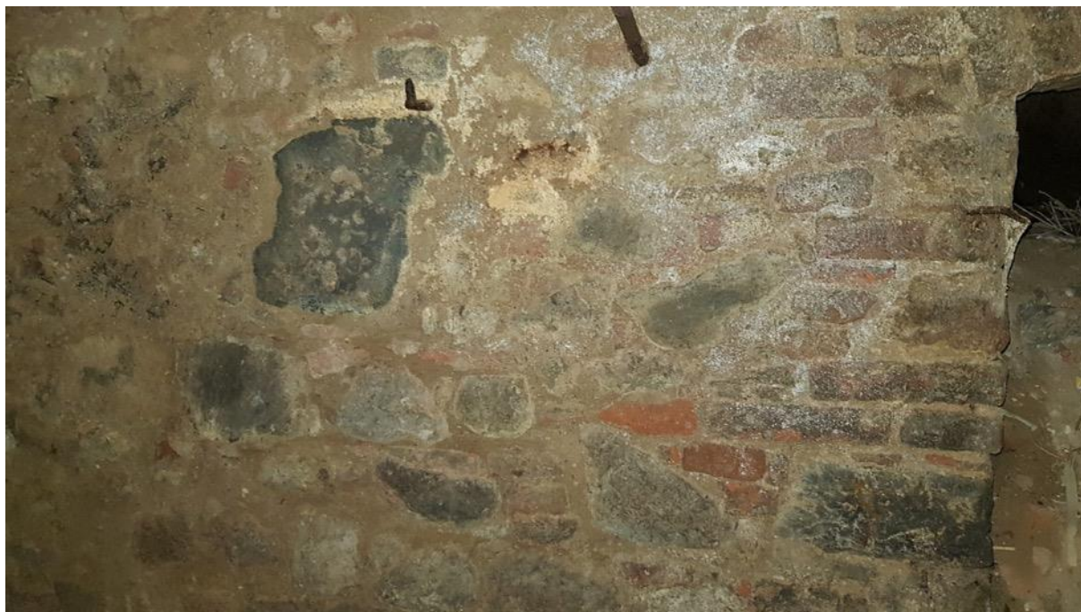
Foto 1: Pohled na sondu Z01 – smíšené zdivo
