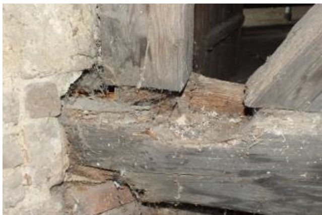
1) Poškození činností dřevokazných hub
