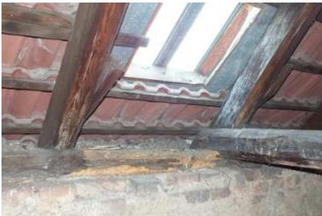
7) Poškození činností dřevokazného hmyzu
