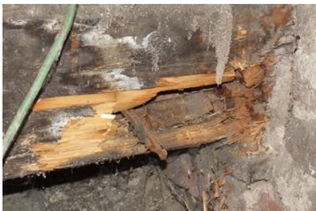
3) Poškození činností dřevokazných hub
