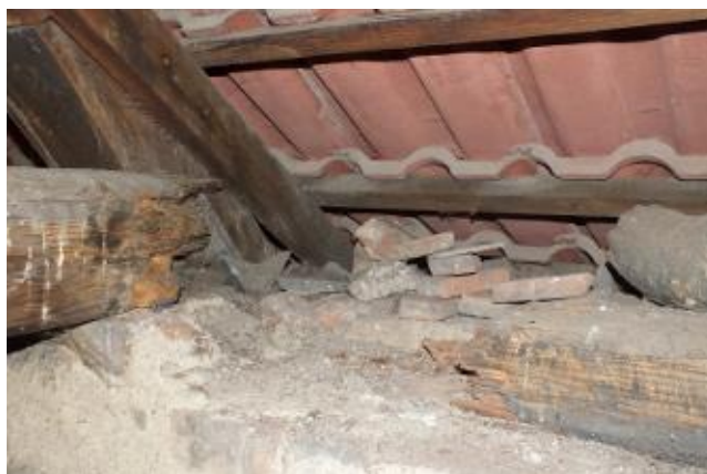
4) Poškození kombinovanou činností dřevokazných hub a hmyzu
