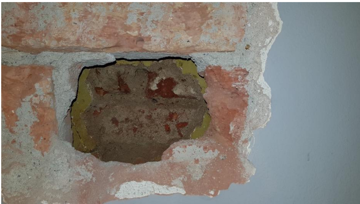
Foto 7: Pohled na sondu Z07 – cihelné zdivo
