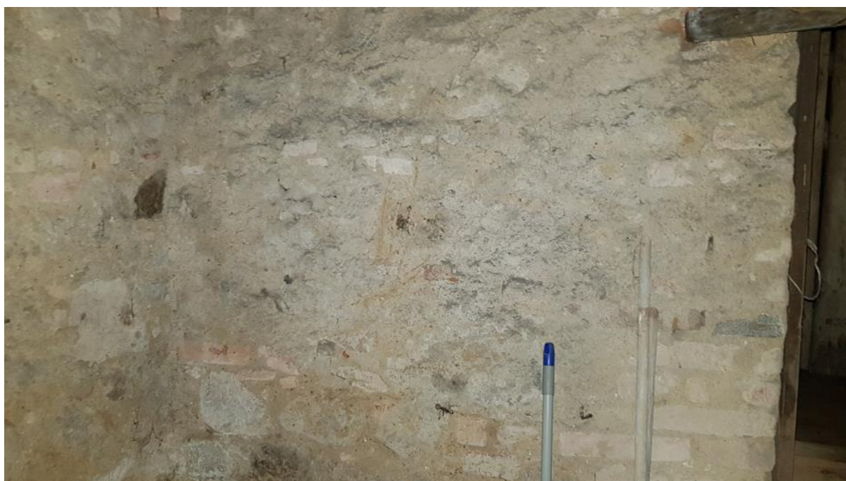
Foto 2: Pohled na sondu Z02 – smíšené zdivo
