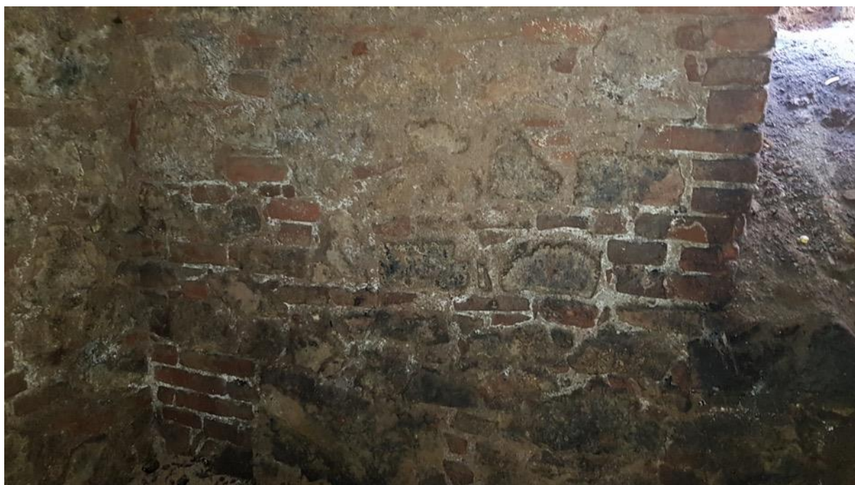
Foto 4: Pohled na sondu Z04 – smíšené zdivo
