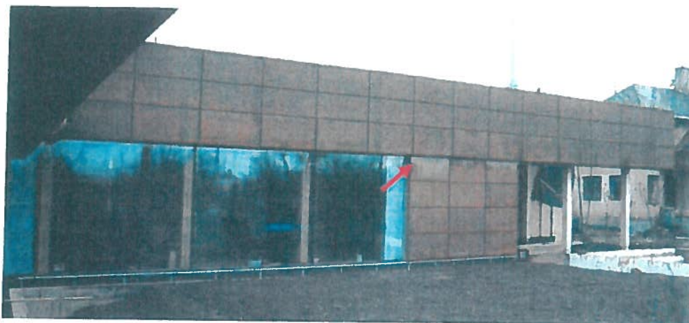
Obr. 1 Vyznačená místa zapuštěného nadpraží v době realizace, kde je postup získání patinace výrazně pomalejší než ve zbývajících plochách vystavených dešti.
