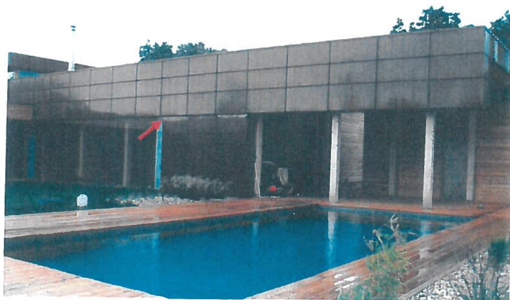
Obr. 2 Vyznačená místa zapuštěného nadpraží po jednom roce od realizace – vytvoření patiny je stále velmi rozdílné.
