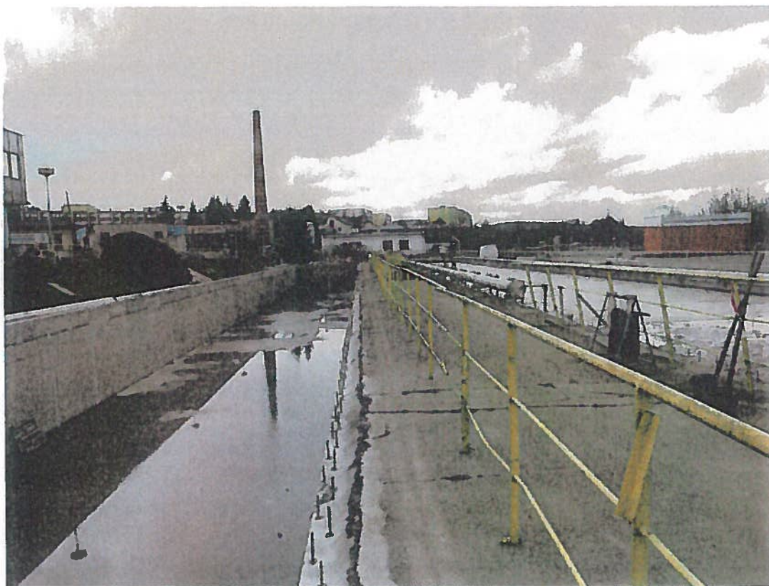
Strop kolektoru – popraskané konstrukce
