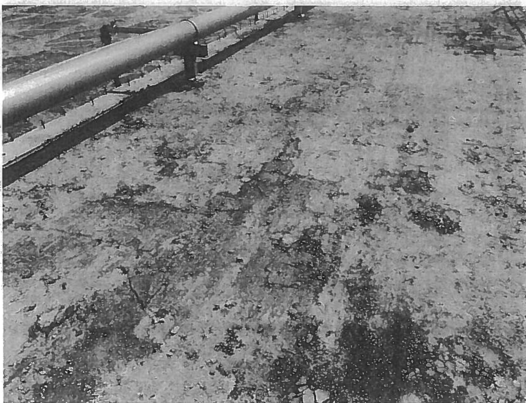
Strop koléktoru – narušená izolace
