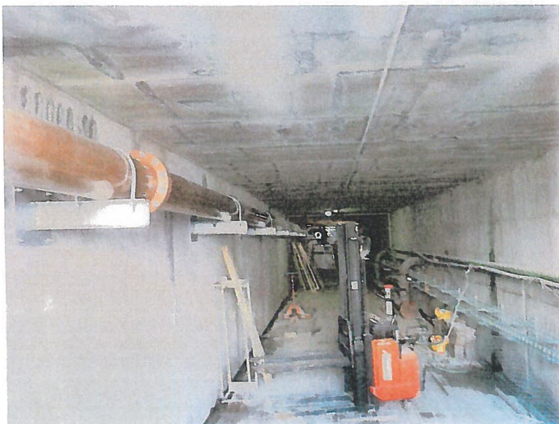
Strop kolektoru – zatékání do kolektoru
